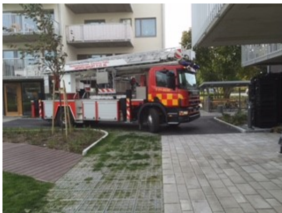
Exempel 1: För kort svängradie och utstickande byggnadsdel förhindrar framkomlighet till uppställningsplats
