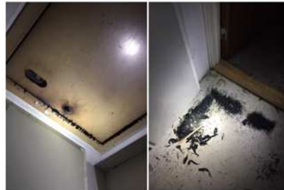
Foto. Brandspridning i bjälklag/förråd. Källa: Räddningstjänsten
