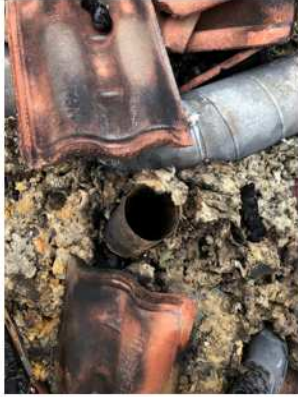
Foto. Brandspridning via rör anslutning till schakt. Källa: Räddningstjänsten
